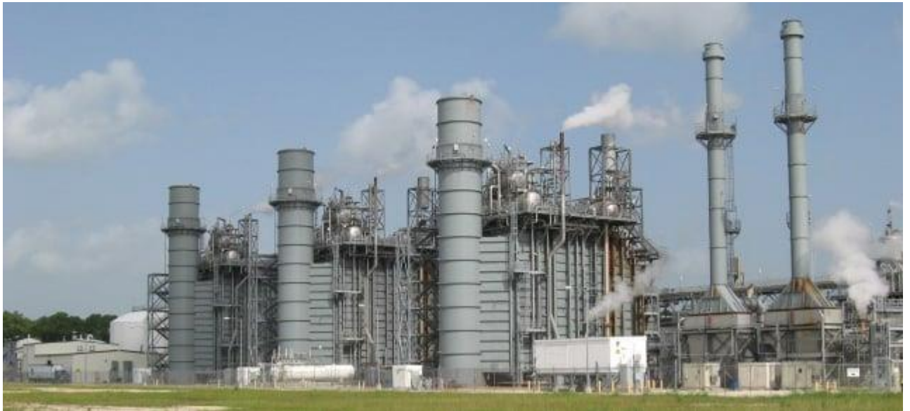
Енергетичний центр у місті Бейтауні (Джерело: Calpine)
